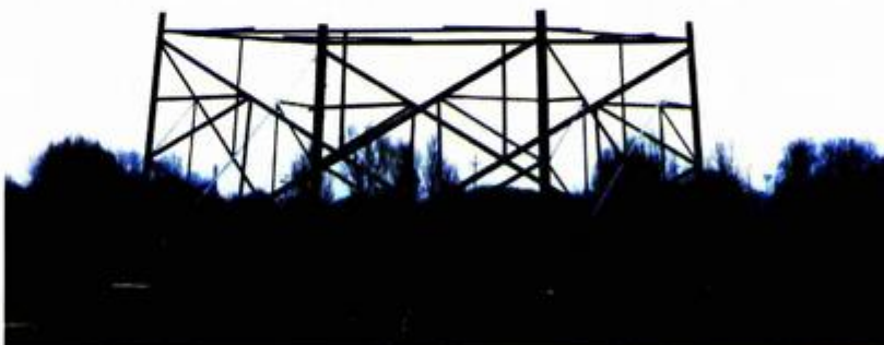
Obilno blato i loši vremenski uvjeti nisu zaustavili radove na trasi dalekovoda ni kod stupnog mjesta 92, uz prometnicu Jagodnjak – Novi Bolman
